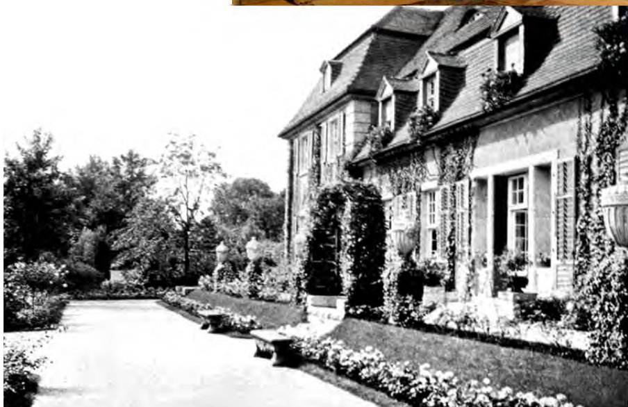
Villa Oppenheim, Ostfassade, 1912
