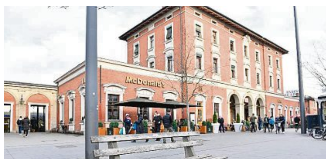
Der Pasinger Bahnhof: An der Nordseite, auf der anderen Seite der Gleise, ist ein Studentenwohnheim geplant.
