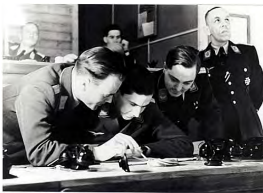
Dienst im Bunker der Reichsluftschuttschule, um 1940
