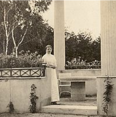
Margarete Marlier an der "Neugierde" auf dem Grundstück
